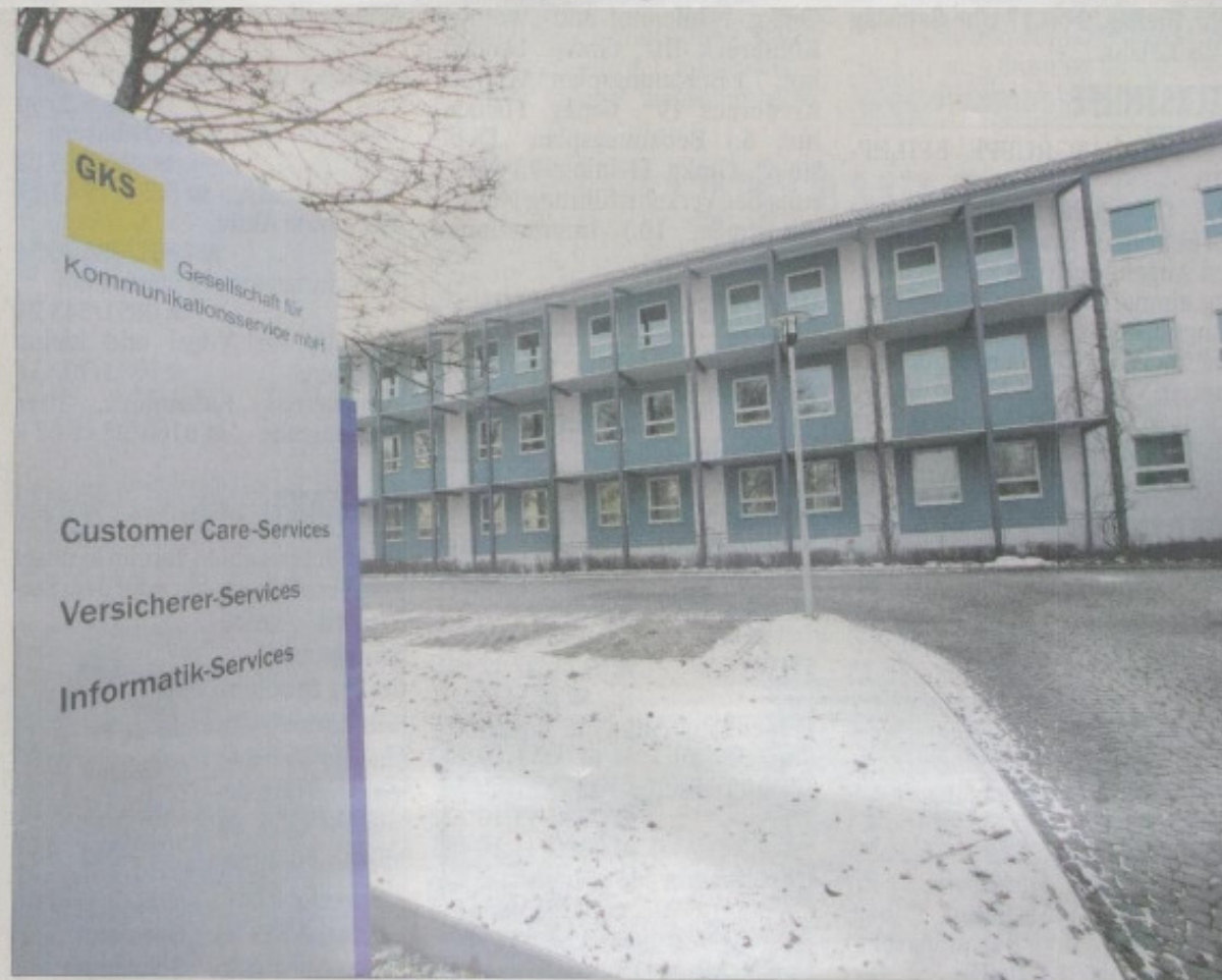
Dieses Firmengebäude an der Messestraße stockt die GKS um ein viertes Geschoss auf.
